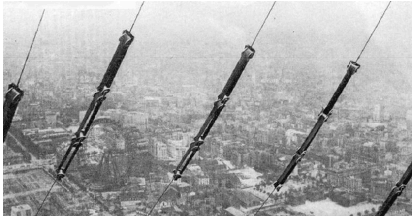
Isolateurs de l'antenne à 300 m de haut (sommets de la tour Eiffel) crédit Photo Site internet de la tour Eiffel et musée des armées
